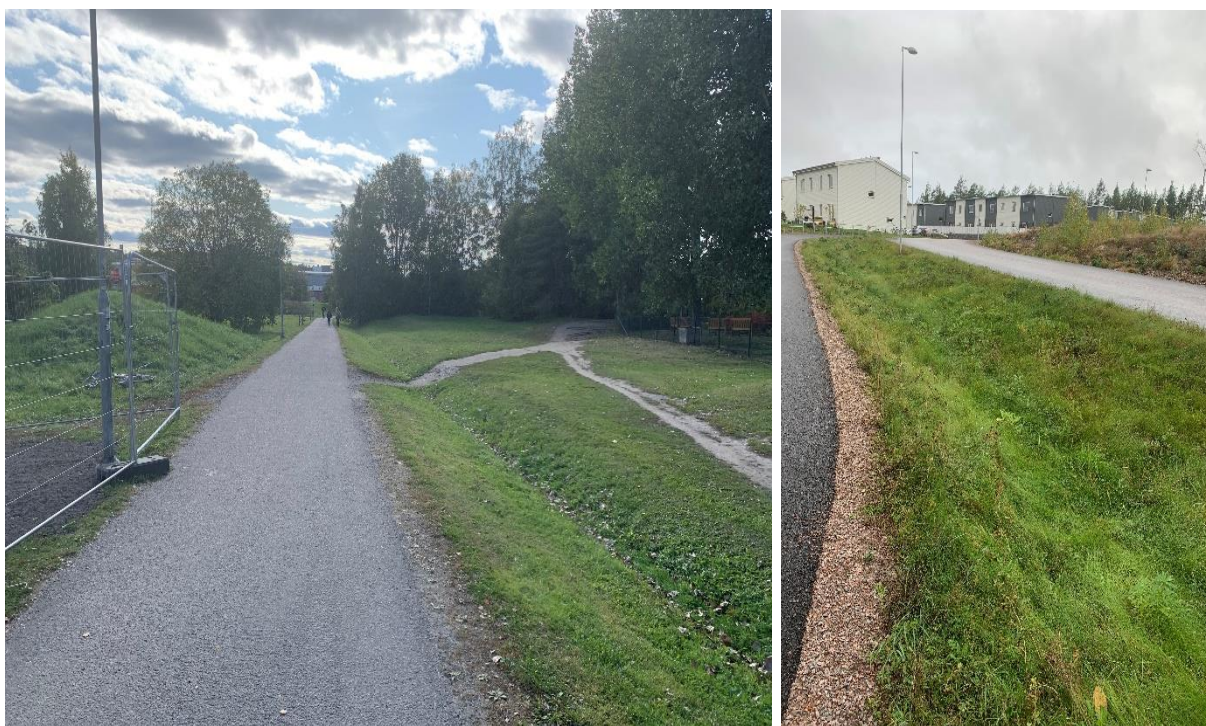
Figur 18. Diken längs med vägar och gång- och cykelbanor är ett bra sätt att rena, fördröja och avleda dagvatten. Exempelbilder från Vallentuna och Karlstad. (Foto: Bjerking).
